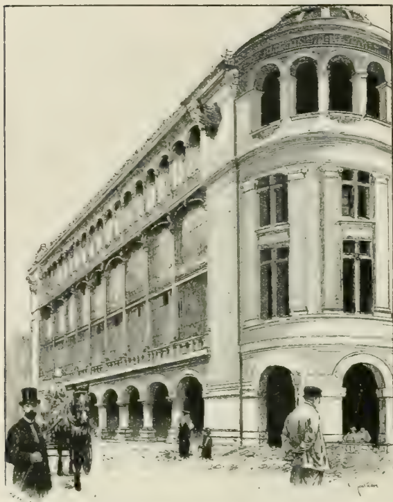
Fig. 143. — Le nouvel Hôtel des Téléphones, situé à côté de l'Hôtel des Postes, rue Gutenberg. — Dessin de Montader, d'après une photographie instantanée.
