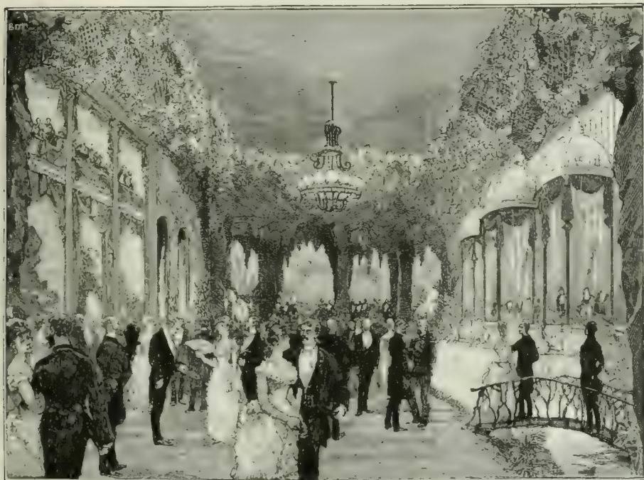
Fig. 146. — Transformation de la cour de l'Hôtel Continental lors de la fête de l'Hospitalité de nuit (1886). D'après un dessin de M. Gérardin ( Monde illustré , 8 mai 1886).
